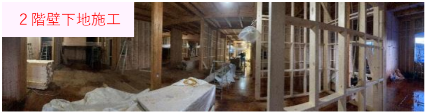
2階壁下地施工
